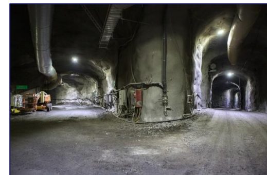
De bouw van een testtunnel
